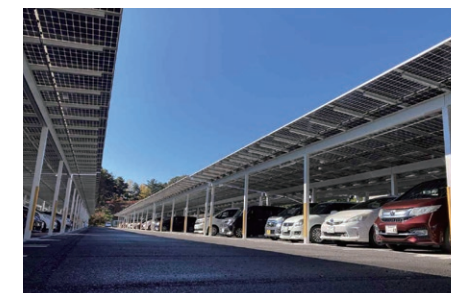
福島県白河市 事業所従業員駐車場 駐車台数：644台 DC容量：1956.2kw
