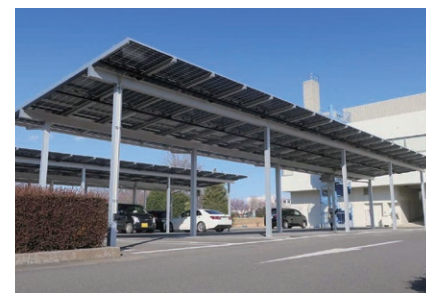
茨城県つくば市 研究施設駐車場 駐車台数：20台 DC容量：57kw
